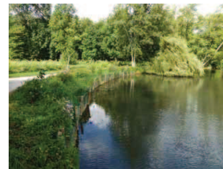
Exemple de travaux de restauration de berges par des techniques de génie végétal.
